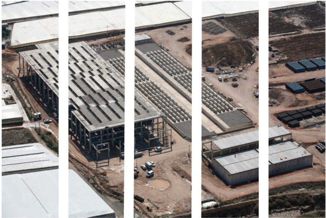
Desaladora del Campo de Dalías, en Almería, en construcción, que garantizará totalmente las necesidades de agua de la agricultura y del abastecimiento urbano, y reducirá la sobreexplotación actual de los acuíferos.
