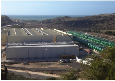
Desaladora de Beni Saf (Argelia) en construcción
